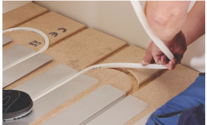
Figur 10 Montering av värmeslangar.
